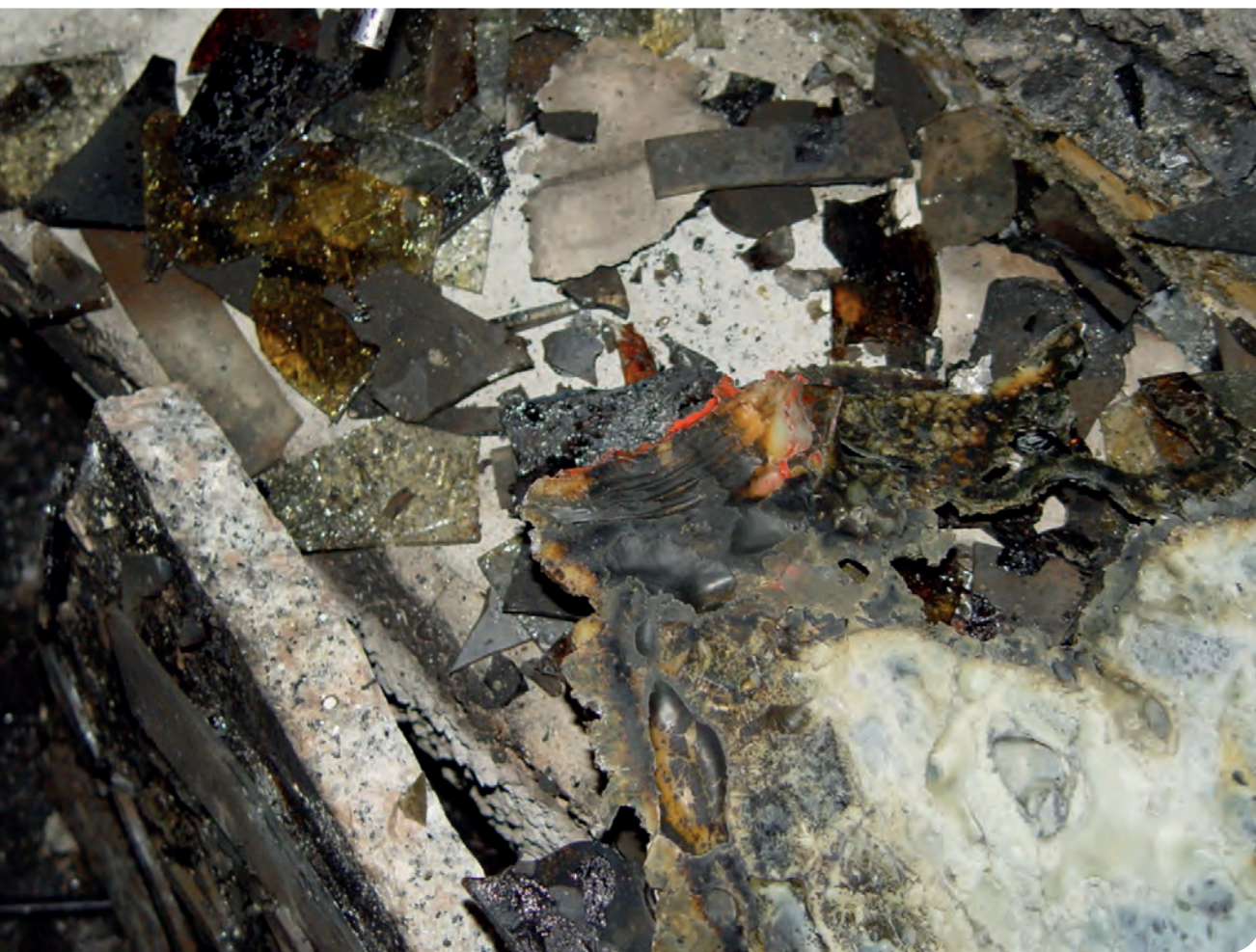
Foto 2 | Presenza di inneschi incendiari
